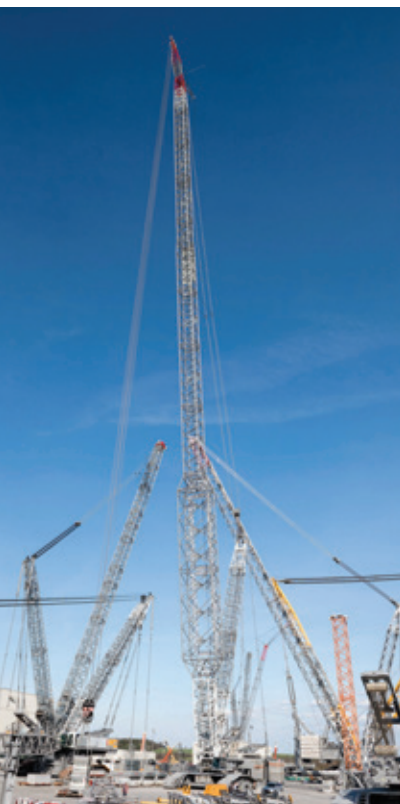
Com o sistema SX podem-se elevar cargas de até 120 toneladas.
