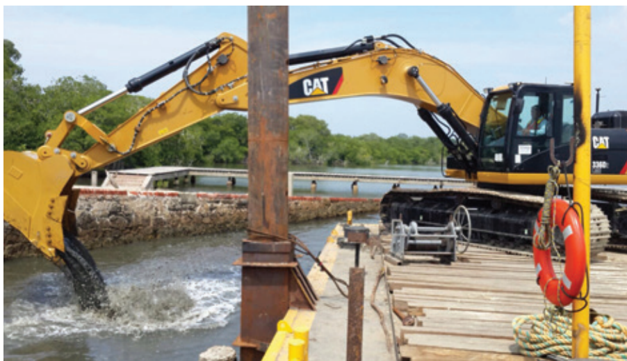
Obras de proteção de costa em Cartagena de Índias.
