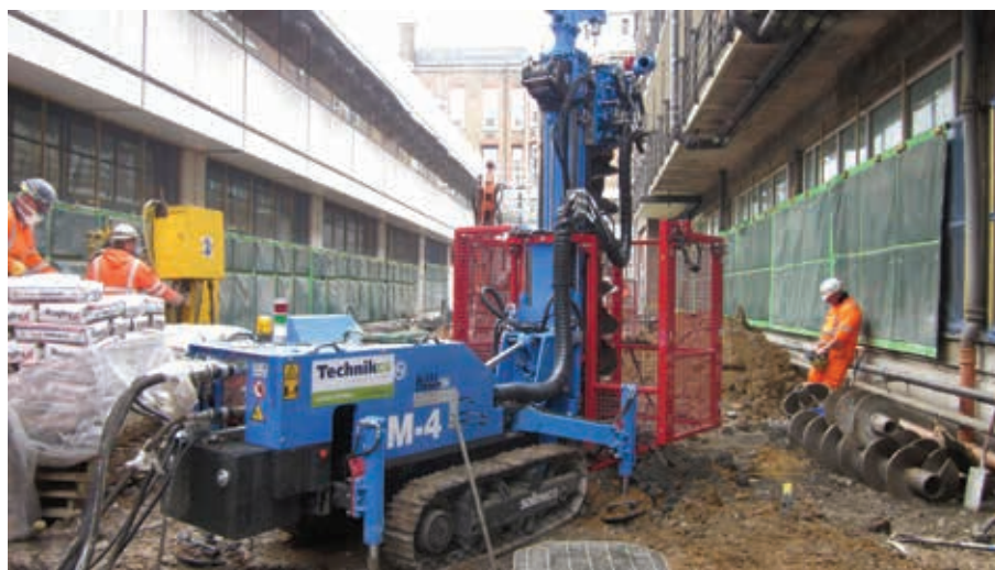
La micropiloteadora de Soilmec SM-4 fue recientemente presentada al mercado mundial y sirve para espacios confinados.
