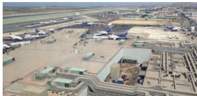
La ampliación del Aeropuerto Jorge Chávez de Lima se iniciará este año.
