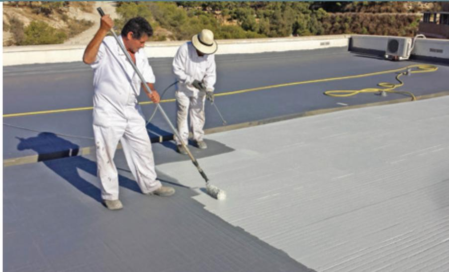
**Os produtos usados na impermeabilização variam de acordo com o tipo de superfície, a localização geográfica do projeto, resistências mecânicas, entre outros fatores.**
