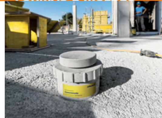
O sistema de sensores Concremate, que permite controlar e agilizar o processo de desforma, é uma das novidades da DOKA.
