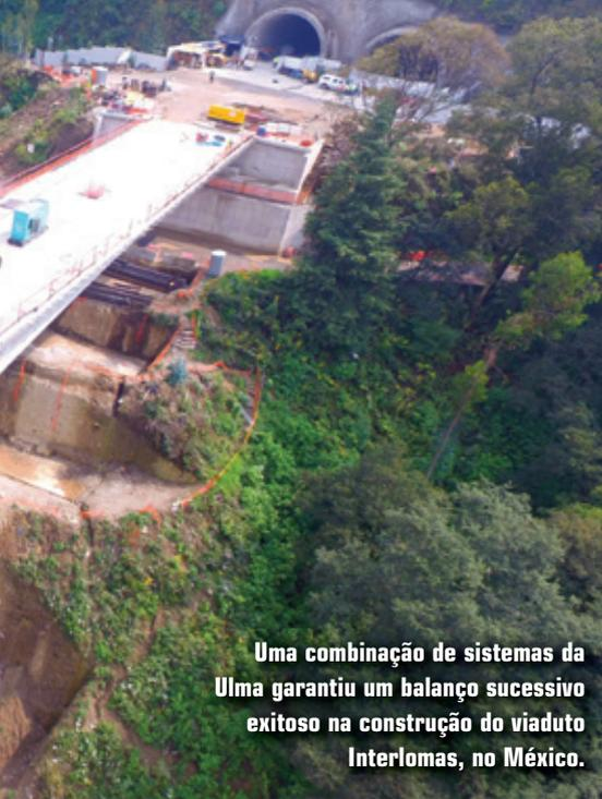
Uma combinação de sistemas da Ulma garantiu um balanço sucessivo exitoso na construção do viaduto Interlomas, no México.
