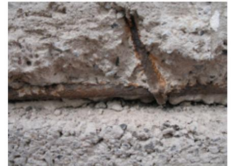
**Uma impermeabilização mal feita pode provocar fissuras no concreto e oxidação das estruturas.**
