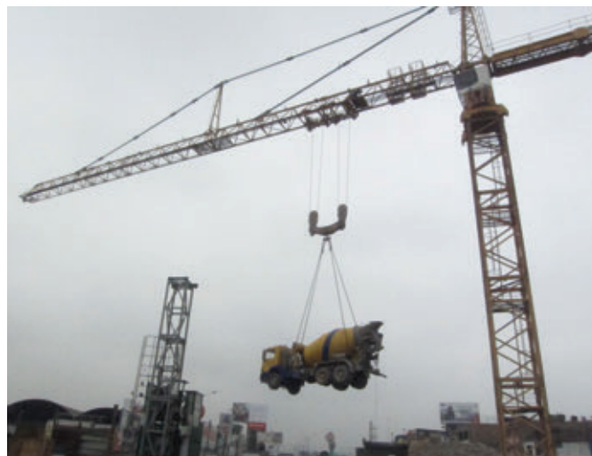
Dois guindastes torre 550EC-H 40 Litronic trabalham na linha 2 do metrô da capital peruana.
