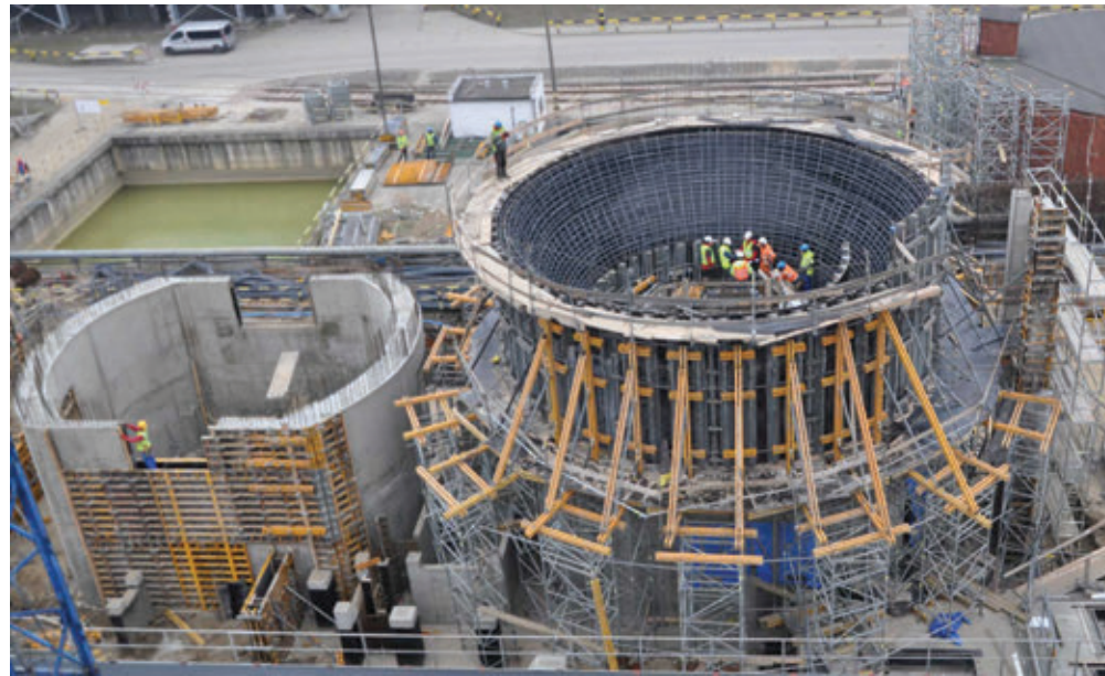
O novo sistema Biramax da Ulma está pensado para estruturas curvas com raio mínimo de 2 metros.
