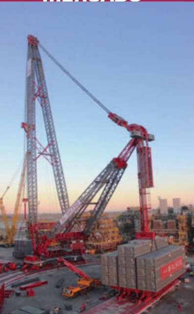
O equipamento está no Rio de Janeiro, onde ajuda a montar um navio plataforma.
