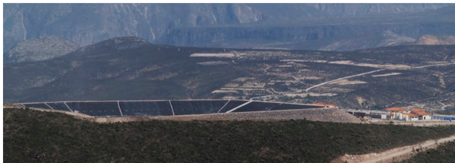
O Aqueduto II de Querétaro, com um trajeto de 128 quilômetros, foi considerado a obra hidráulica mexicana mais importante desde 1738.
