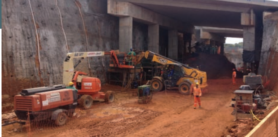
A CCR se viu forçada a construir passagens subterrâneas que transformaram trechos de estradas em viadutos.
