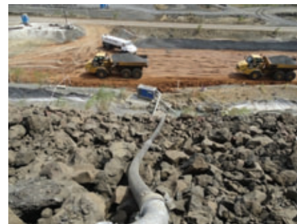
As bombas da BBA Pumps trabalharam com grande intensidade no Canal do Panamá.
