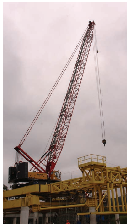
Dois guindastes Sany modelos SCC1800 e SCC2500C operam na construção do trecho leste do Rodoanel Mário Covas, em São Paulo.
