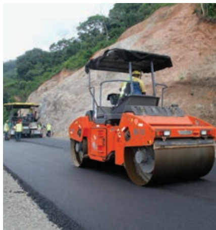
Compactação do trecho dois entre Viguí e San Félix, a cargo da costarricense MECO por US$260 milhões.
