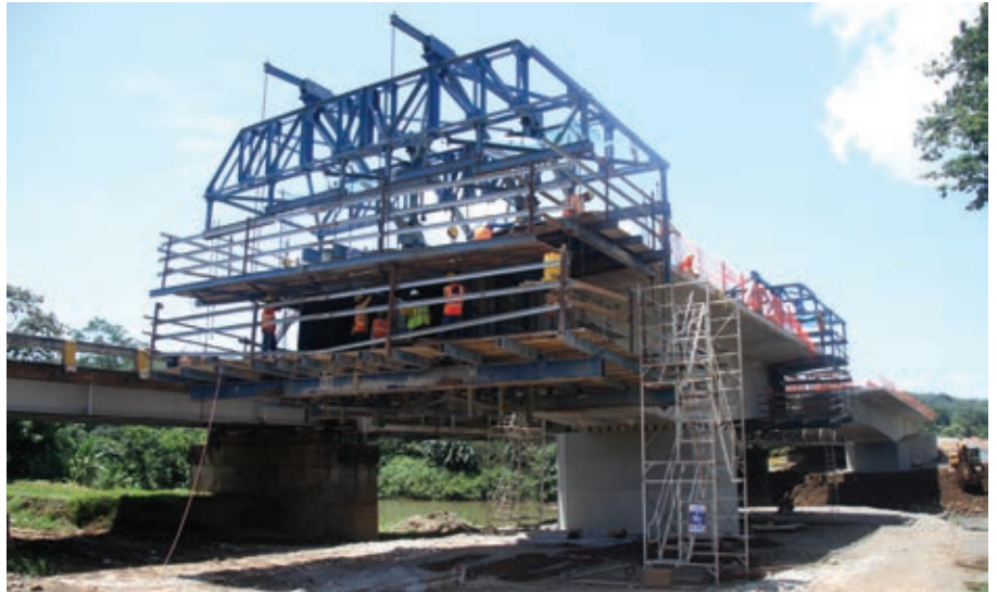
Ponte sobre o trecho quatro, feita pelas empreiteiras CONALVIAS e RODSA, por cerca de US$220 milhões.
