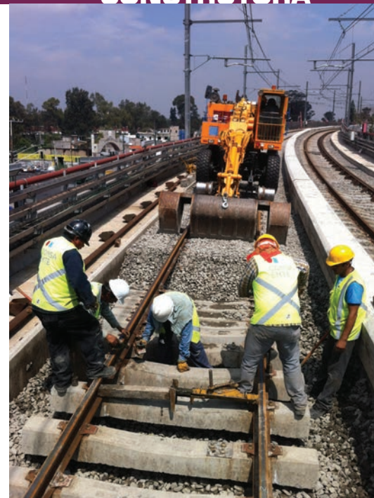
Reabilitação e manutenção da linha L12 do metrô da Cidade do México.
