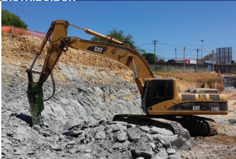
A retirada de arenito para a construção de um shopping center pela empresa Delta foi assessorada pela Maxter, que forneceu os martelos All Work.
