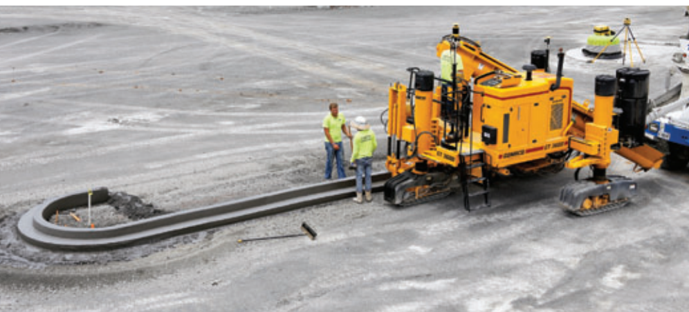
A Gomaco exibiu sua pavimentadora GT 3600.
