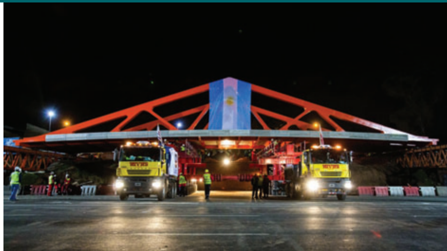
A ALE Lift realizou a montagem e desmontagem de várias pontes sobre a Av. General Paz, em Buenos Aires.
